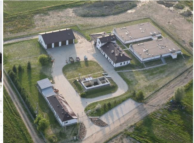
Rys. 59. Oczyszczalnia ścieków Zarszyn źródło: www.zarszyn.pl
