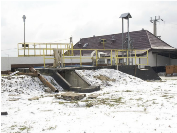
Rys. 58. Oczyszczalnia ścieków Zarszyn źródło: www.novum.biz
