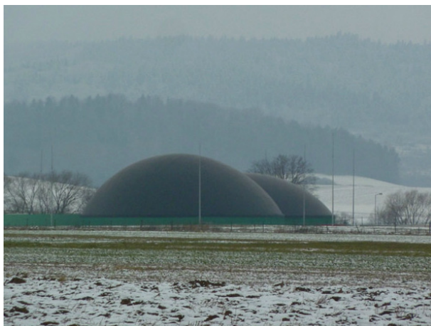
Rys. 109. Widok biogazowni źródło: www.odrzechowa.izoo.krakow.pl
