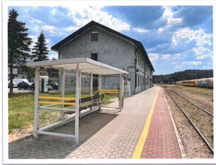
Fotografia 11. Stacja kolejowa Zagórz
