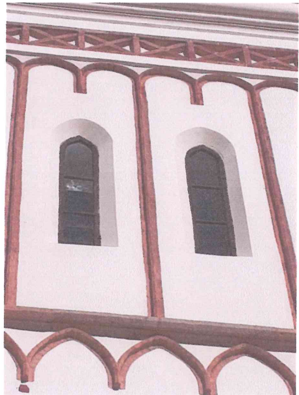
Fot. nr 15. Okna w wieży kościoła, strona południowa, widok ogólny.
