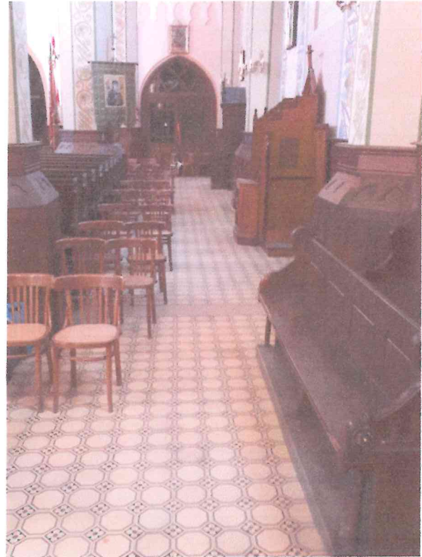
Fot. nr 7. Nawa zachodnia, widoczne cementowe uzupełnienia posadzki
