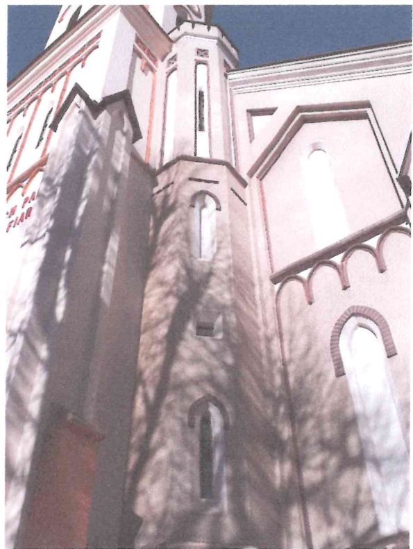
Fot. nr 17. Okna w wieży kościoła , strona wschodnia, widok ogólny.
