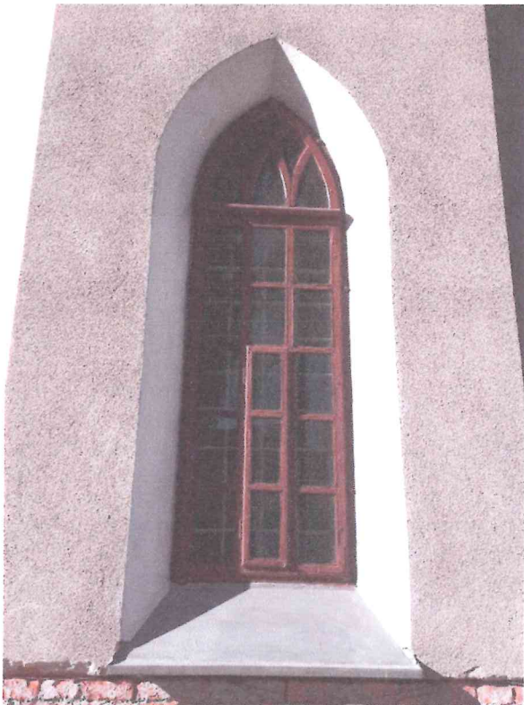
Fot. nr 14. Okno w zakrystii wschodniej, widok ogólny .
