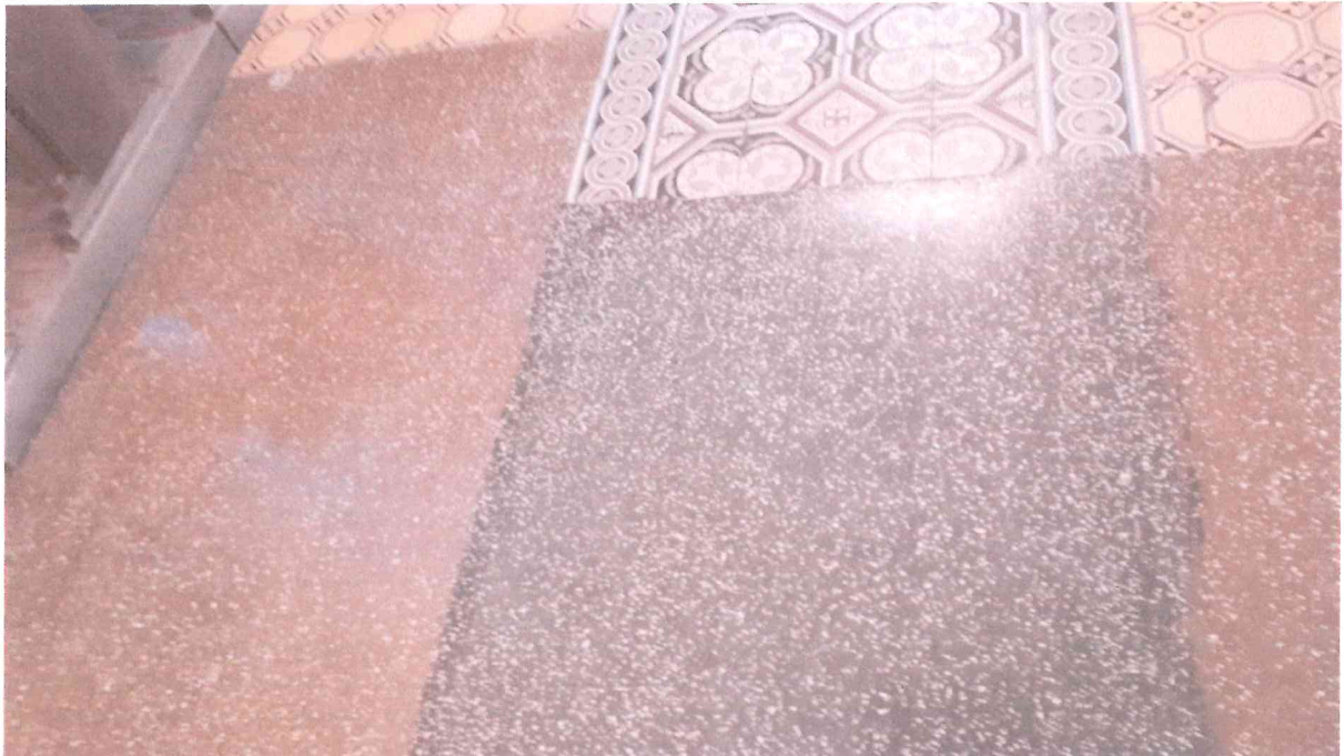
Fot. nr 2. Łata z lastryka w nawie głównej.
